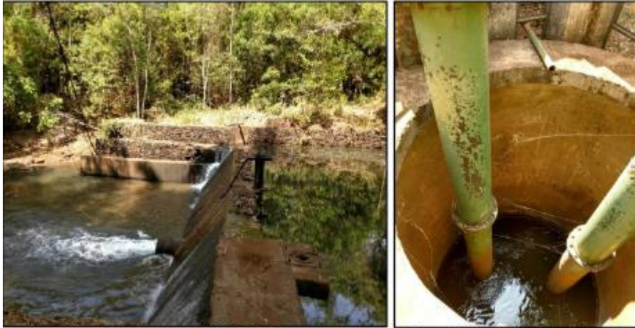
Figura 1 – Barragem de Nível de Captação e Poço de Sucção da EAB
