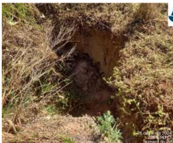
Figura 11 - Área no interior da UC com processo erosivo em estágio avançado. Registro: 26/07/2024
