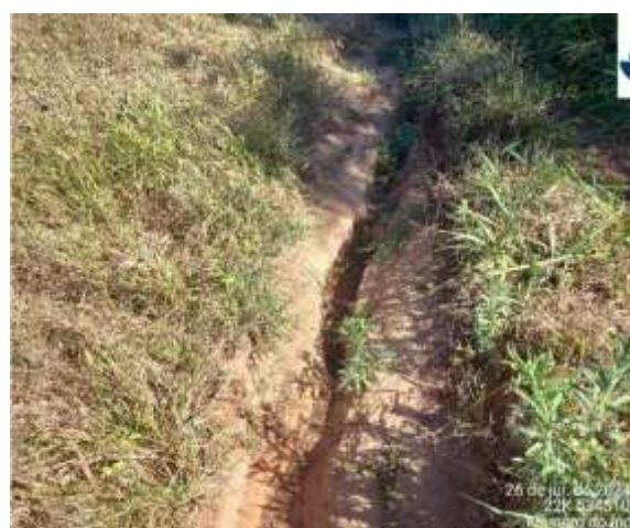
Figura 12 - Processo erosivo em sulco no interior da UC. Registro: 26/07/2024.
